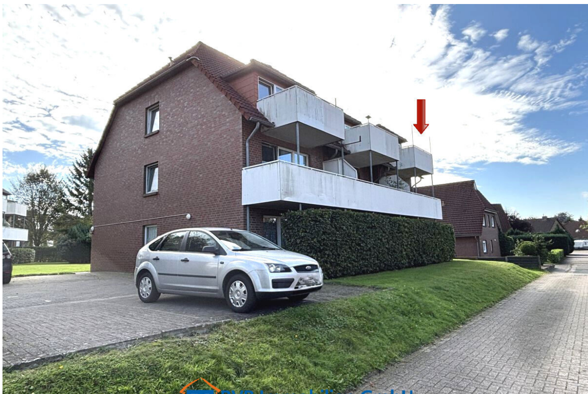
Parkplätze direkt vor der Tür
