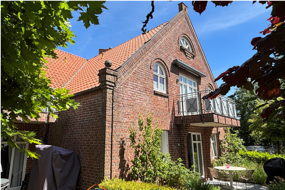
Balkon zur Südseite mit elektr. Marquise
