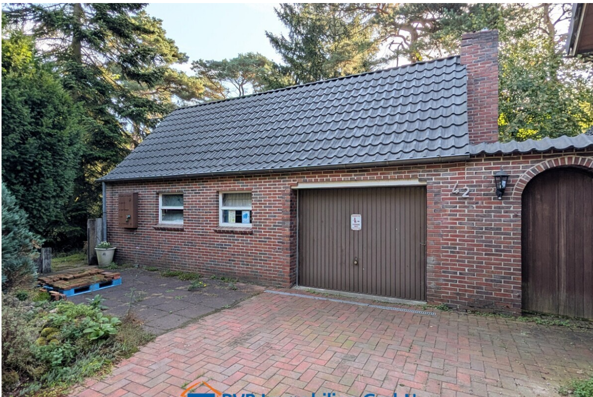
Nebengebäude mit Garage
